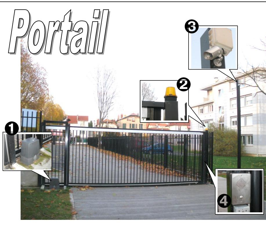
**① Moteur du portail** : moteur basse consommation avec capot étanche, ultra résistant en plastique recyclé, design fluide, gris clair.
